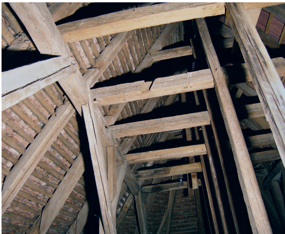
13. Csíkkarcfalva, plébánia-templom. Üres lapolási fészkek a szentély-tetőszerkezet északi szarufáin és a torokgerendákon | Tóth Boglárka felvétele, 2011
