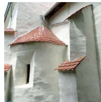
A felújított mellékszentély
