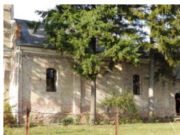
Középkori ablakok és élre rakott téglasor a köröskisjenői ref. templom homlokzatán
