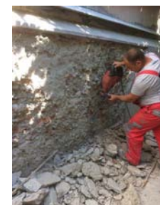
Cementes vakolat eltávolítása a minorita rendház faláról
