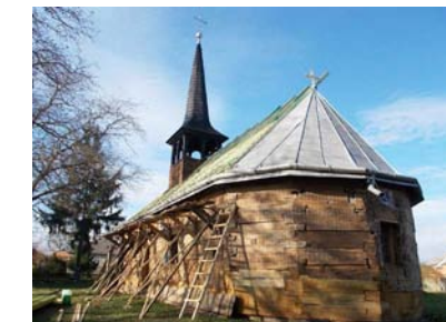
A templom boronafalának újjáépítése
