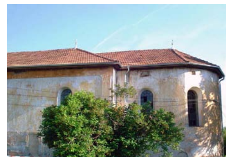
A marosillyei plébániatemplom felújított tetőzete
