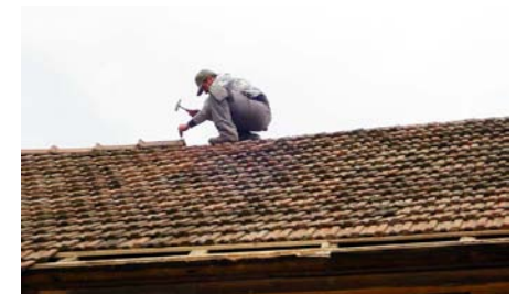
A marosillyei középkori eredetű római katolikus templom cserépfedésének felújítása
