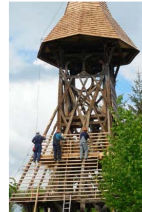
A kálnoki harangláb zsindelyezése
