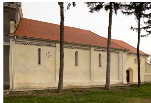
A köröskisjenői ref. templom felújított déli homlokzata
