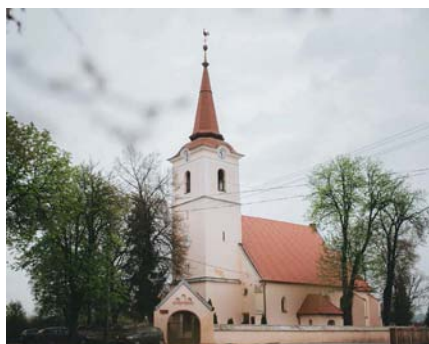
A tornaljai református templom felújított héjazata
