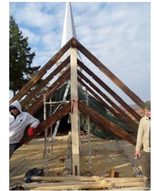
A köröskisjenői református templom új fedélszékeinek építése
