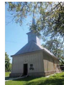
A nyugati homlokzat felújítás előtt
