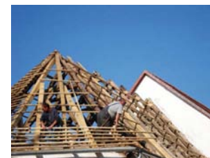
A szentély tetőszerkezetének felújítása
