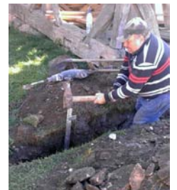
Villámhárító földelése
