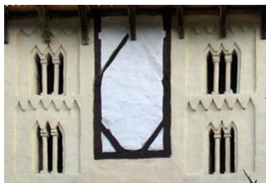
A torony felújított felső szintje
