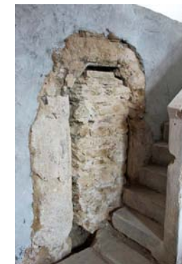
Befalazott középkori ajtónyílás a gidófalvi református templomban
