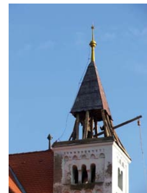
A toronysisak bádogfedésének elbontása
