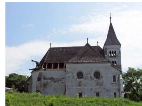
A templom a felújítás kezdetén
