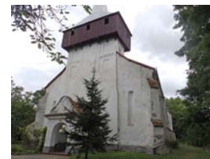
A nyugati homlokzat felújítás előtt
