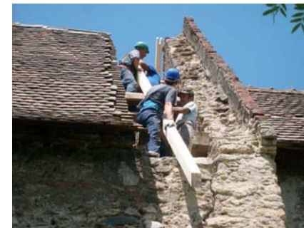
A marosillyei középkori eredetű római katolikus templom tetőfelújítási munkálatai
