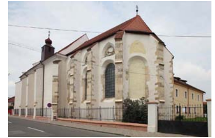
A felújított délkeleti homlokzat
