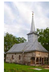
A homlokzat felújítás közben
