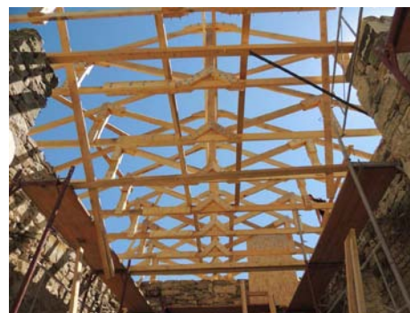
Védőtető épül a romos ormányi református templom fölé
