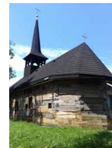
A felújított délkeleti homlokzat
