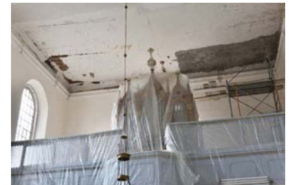
A súlyosan károsodott karzattmennyezet
