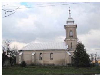
A templom északi homlokzata
