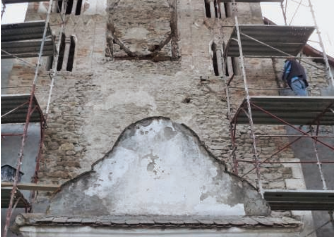
A nyugati homlokzat kutatás közben
