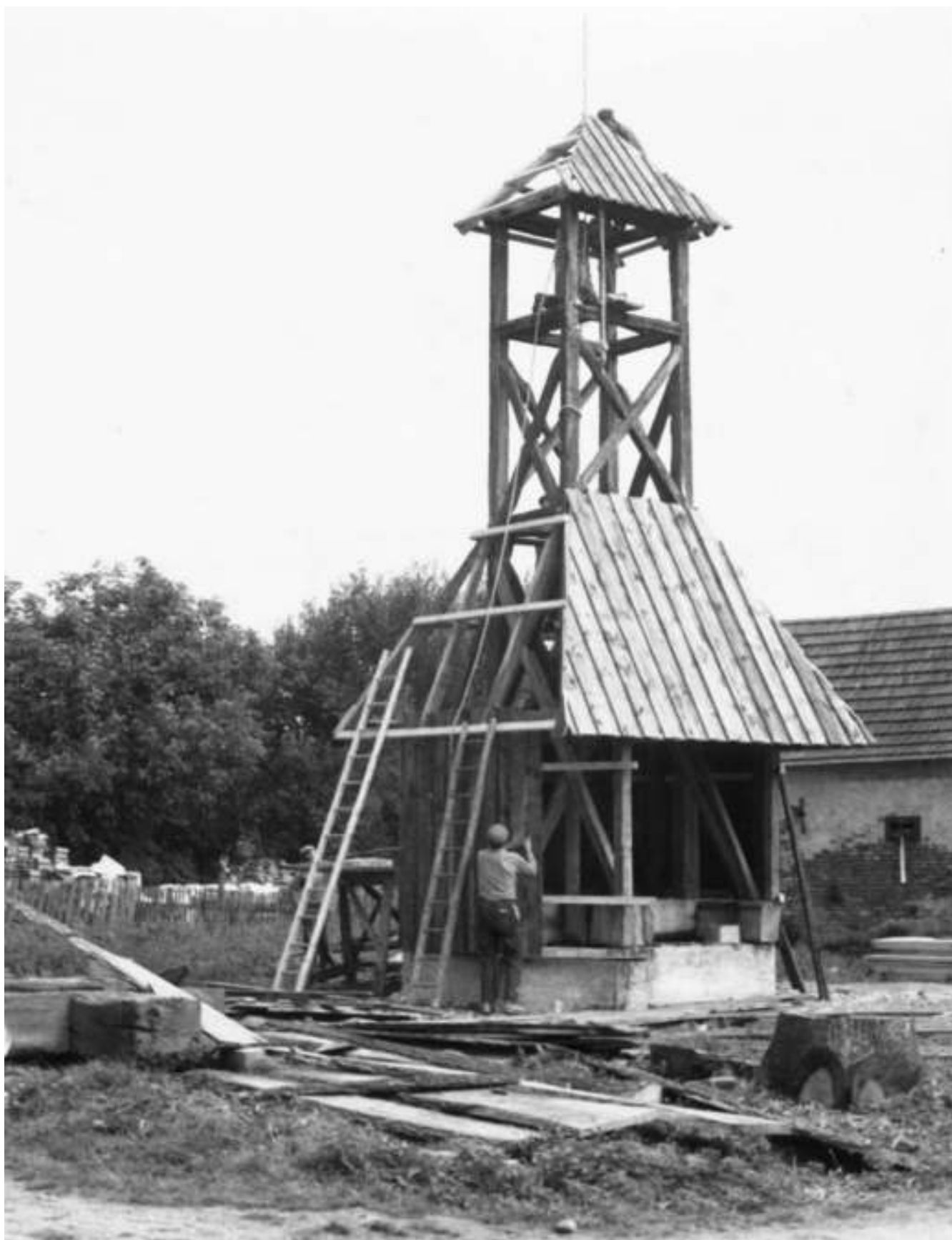
Kámaháza szoknyásharangja építés közben
