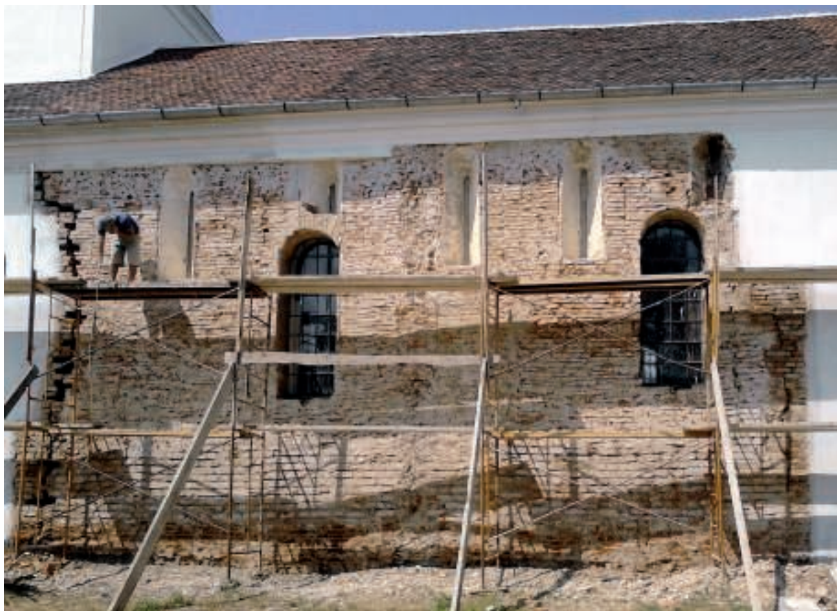
A déli homlokzat felújítás közben
